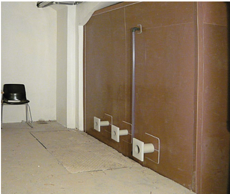
Dvouplášťová izolovaná nádrž na termální vodu
