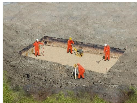
Obrázek 7: Příprava vyrovnaného základu
