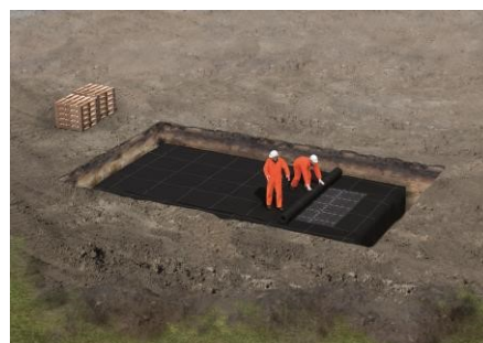
Obrázek 13: Zakrytí geotextilií
