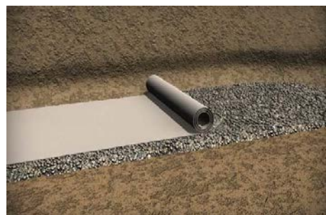
Obrázek 8: Pokládka geotextilie
