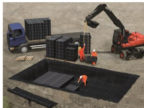
Obrázek 9: Umístění prvků vsakovací galerie
